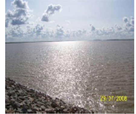
Barrage de Bagré (1,7 M 2 m 3 )
